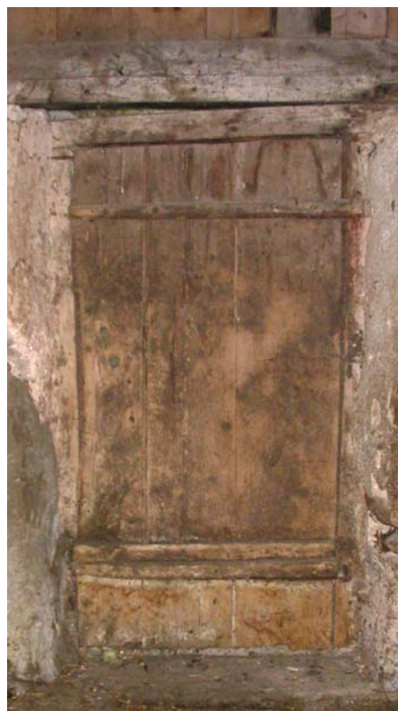
La porte d'écurie séparant celle-ci de la cuisine
