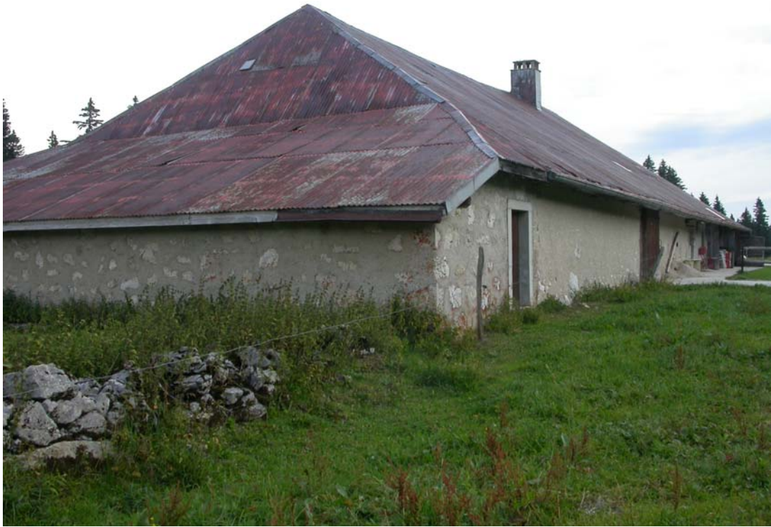
Façade du levant et pignon à bise. Le plan de ce chalet est rectangulaire, avec toit à quatre pans.
