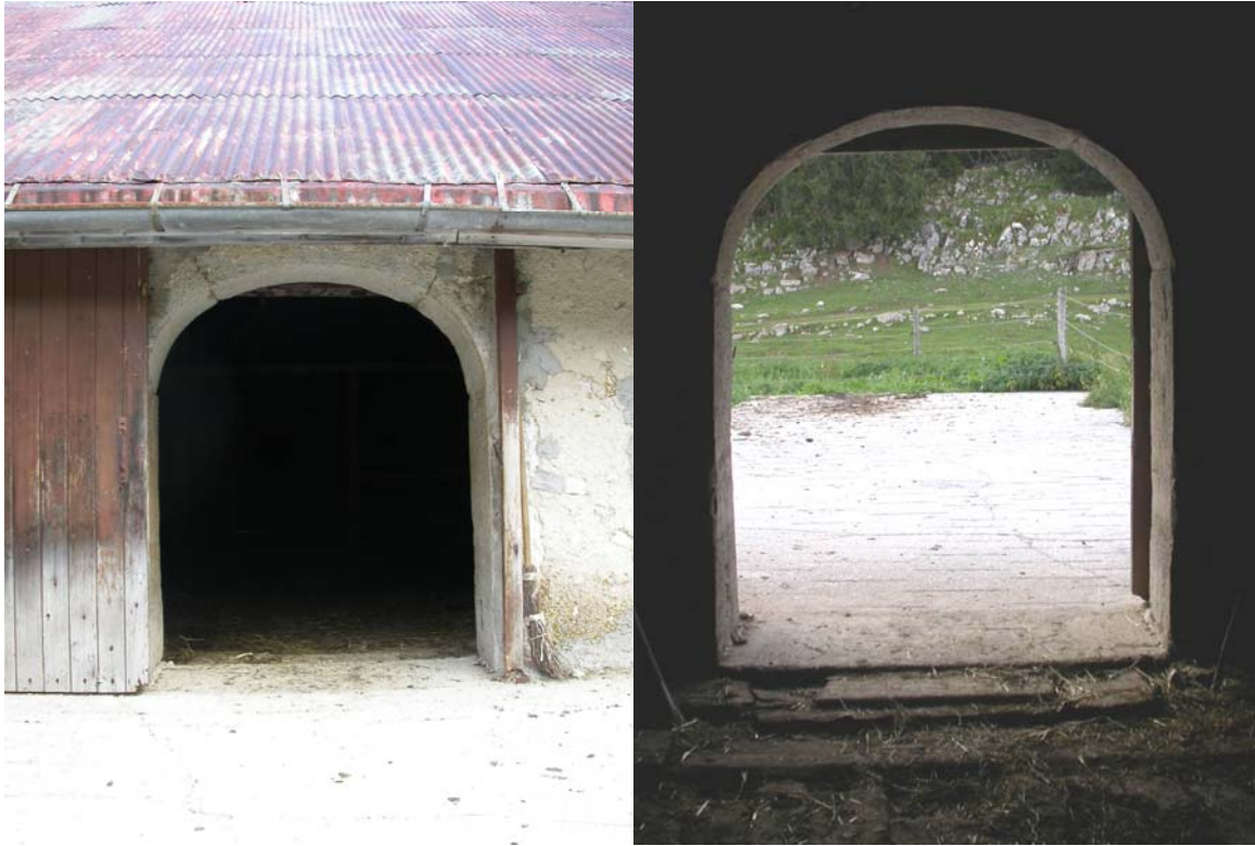
Porte d'écurie vue de l'extérieur et de l'intérieur.
